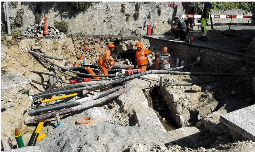
Quelques jours avant la fin du chantier, un tronçon de canal en pierre s'est effondré et a été remplacé par un élément en béton.
