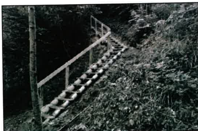
L'escalier récemment construit à Vullyens
