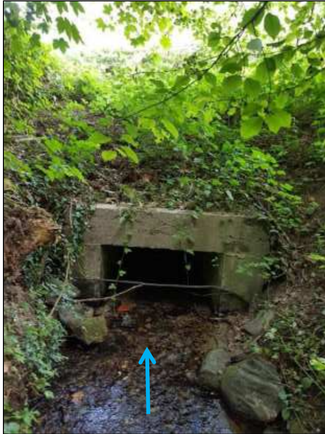
Figure 4 : Photo de l'ouvrage FO-1068-12
