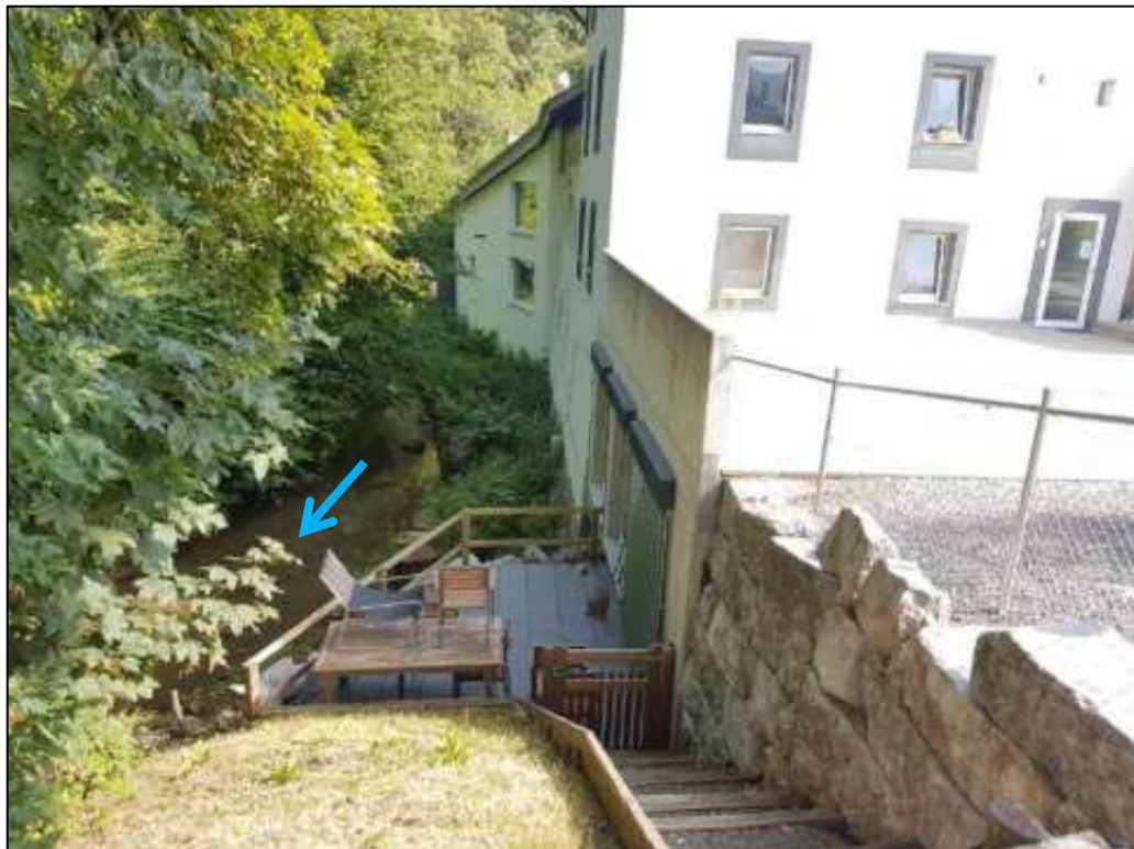
Figure 7 : Photo du bâtiment de la parcelle 227
