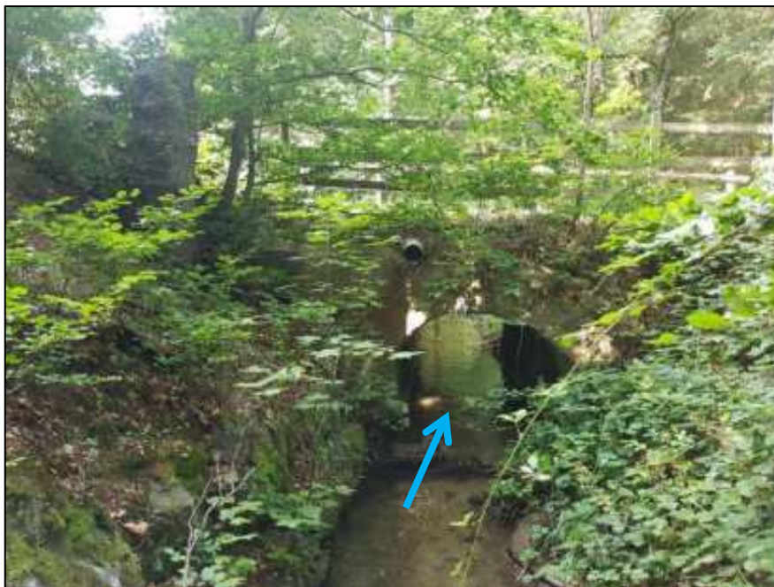
Figure 5 : Photo de l'ouvrage FO-1068-14
